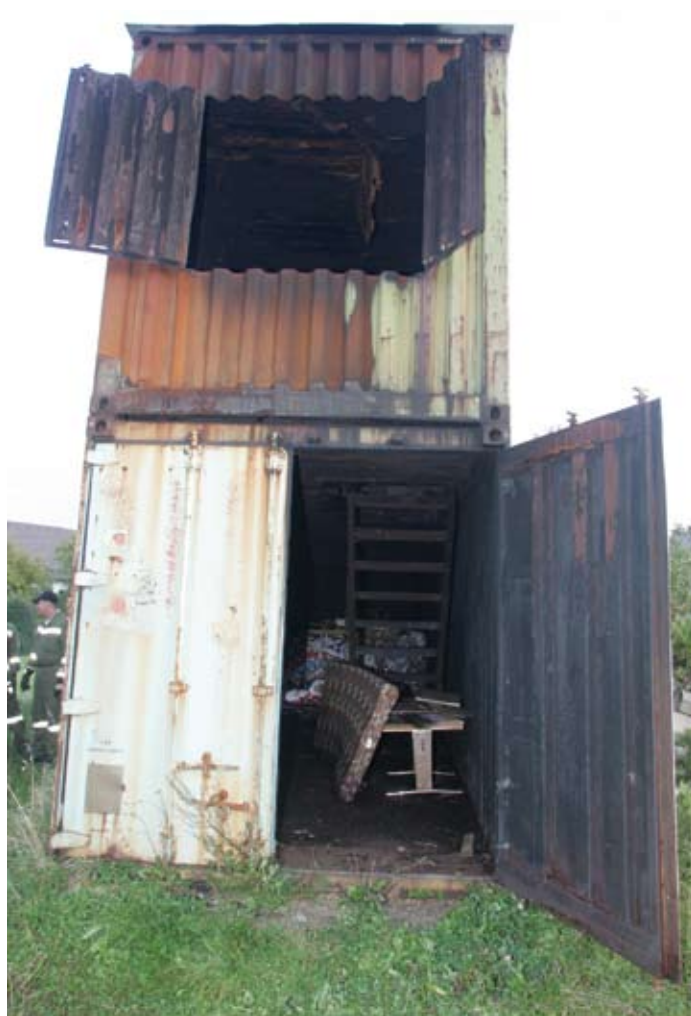
Die beiden Geschosse erlauben auch Innenangriffe über die Schiebleiter oder auch die Vorgangsweise wie bei einem Kellerbrand.
